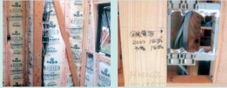
**B** 45×45mm根太を 303mm間隔に配置し、間に断熱材をしきます。
