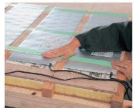
**5** ※切り欠いた溝にリード線はわせ、上から養生テープ等で固定します。(アルミテープでの固定は禁止です) リード線が浮いてこないように、注意して下さい。
